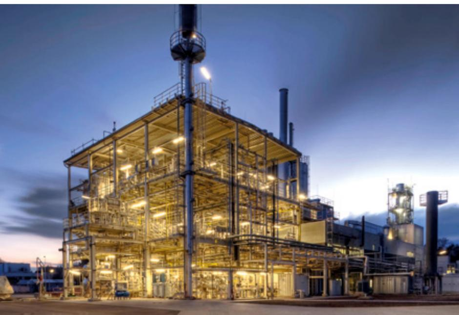
Die bioliq®-Anlage am KIT. In einem mehrstufigen Prozess entstehen aus Stroh und anderen biogenen Reststoffen hochwertige synthetische Kraftstoffe.
